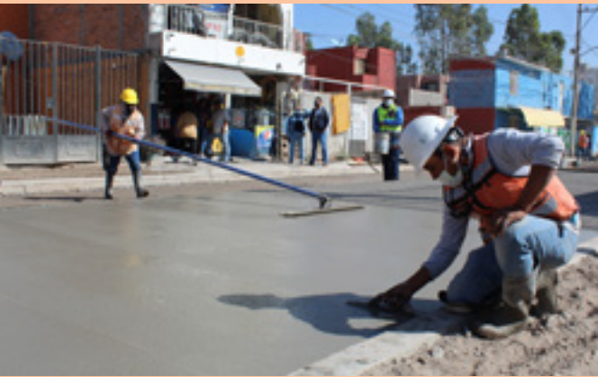
32,358 m² Bacheo con concreto hidráulico
