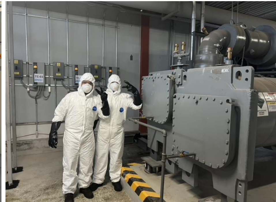
Limpeza química a chillers
