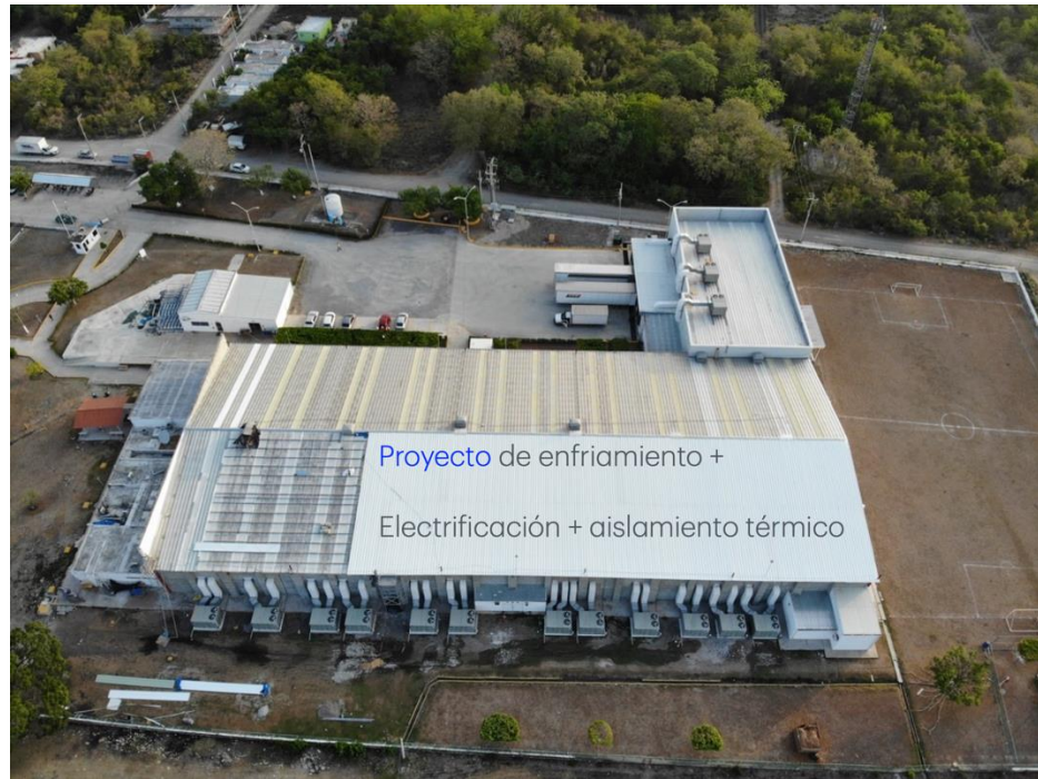
Paquetes, ducto, aislamientos
