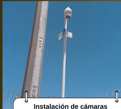
Instalación de cámaras perimetrales bala, domo y ptz
